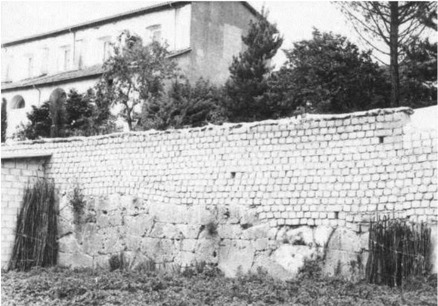
Mura poligonali a sostegno del terrazzo su cui è edificata la chiesa
